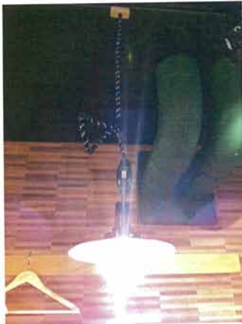
こたつの線で吊り上げた照明。
